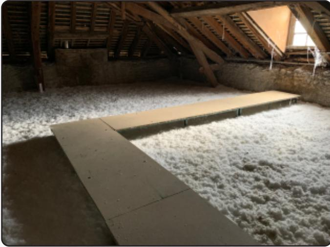
**8** Toujours dans un souci de confort et d'économie, nous avons fait réaliser avec l'aide du SDEPA l'isolation des combles de la mairie. Un chemin de circulation a été réalisé par nos services techniques afin de pouvoir accéder facilement dans les combles, notamment à l'horloge, la cloche et autres points techniques.
