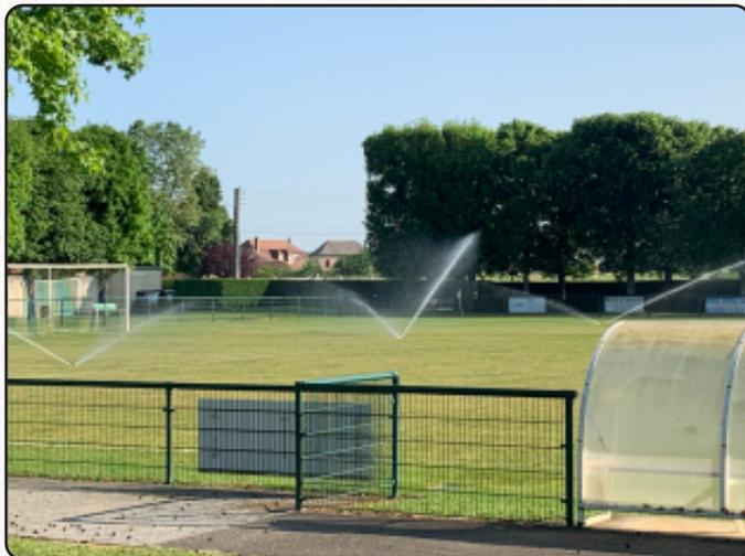
**5** Afin d'optimiser l'arrosage du terrain et éviter ainsi une importante consommation d'eau et d'engrais, le système d'arrosage du stade d'honneur a été entièrement refait. Une réserve d'eau de 50 m<sup>3</sup> est stockée dans une bache à proximité du terrain afin de ne pas être en manque d'eau durant les périodes d'arrosage. Un forage dans la nappe phréatique permet de remplir cette bache entre deux irrigations.
